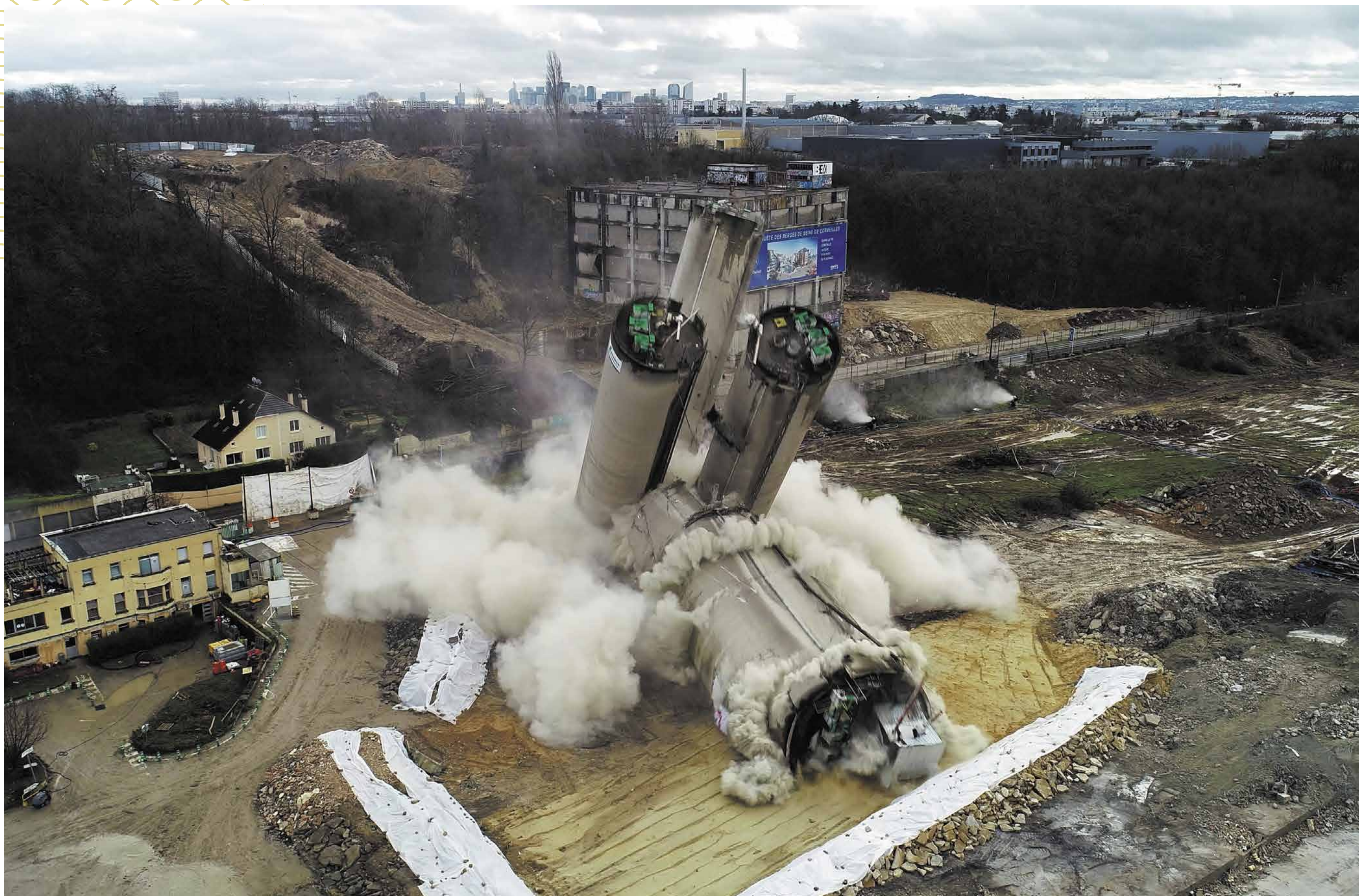
Février 2020 : les silos de l'ancienne cimenterie Lafarge sont foudroyés. Il n'a fallu que quelques secondes pour faire tomber ces quatre ouvrages en béton de 42 m de haut.
