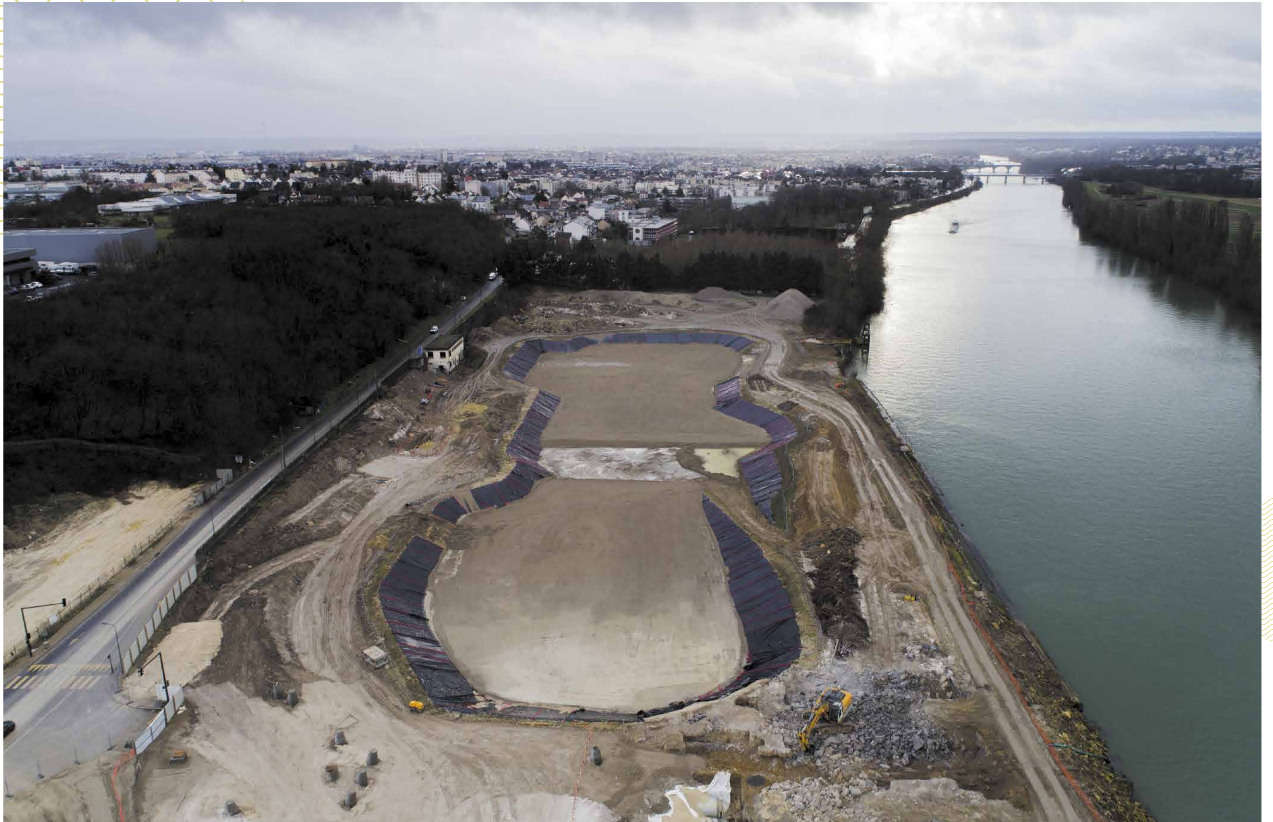
Février 2022 : après la dépollution du site et des travaux préparatoires du bassin, de mars à décembre 2021, on aperçoit pour la première fois les contours de la future marina de 110 anneaux. La pièce maîtresse de ce futur quartier ! © Devisubox
